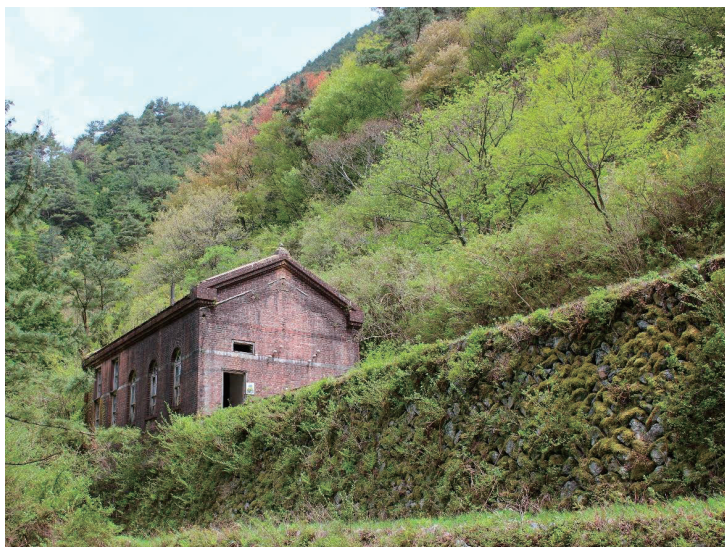
だいさんへんでんしよ ▲ 第三変電所
