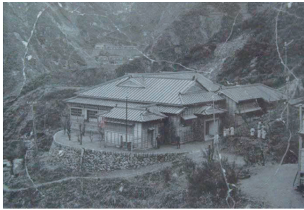
▲ 建設当時の接待館 全景 明治40年代撮影 別子銅山記念館所蔵
