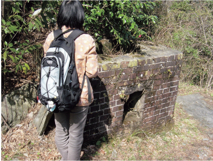
こうすいろかいしょ ▲ 坑水路会所
