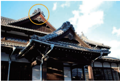
ぶとくでん しょうめん ◀ 武徳殿の正面 ちどり は ふ 千鳥破風
