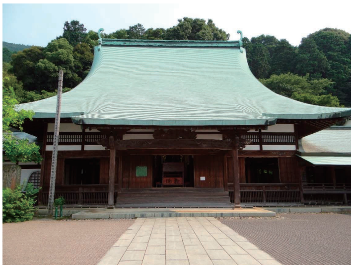
▲ 瑞応寺の本堂 本堂の屋根は、別子銅山の銅で葺かれている
