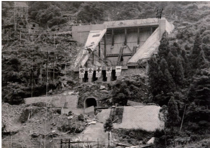
▲ 建設中の粗鉱ビン 別子銅山記念館所蔵
