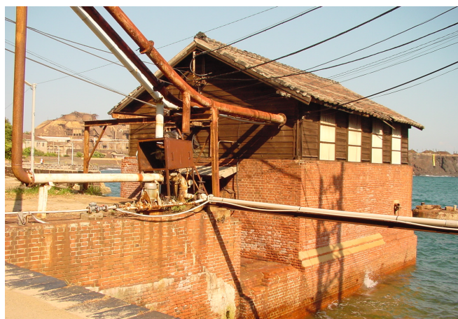
ポンプ小屋(明治40年完成)
