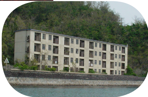
社宅団地 (昭和41年建設)
